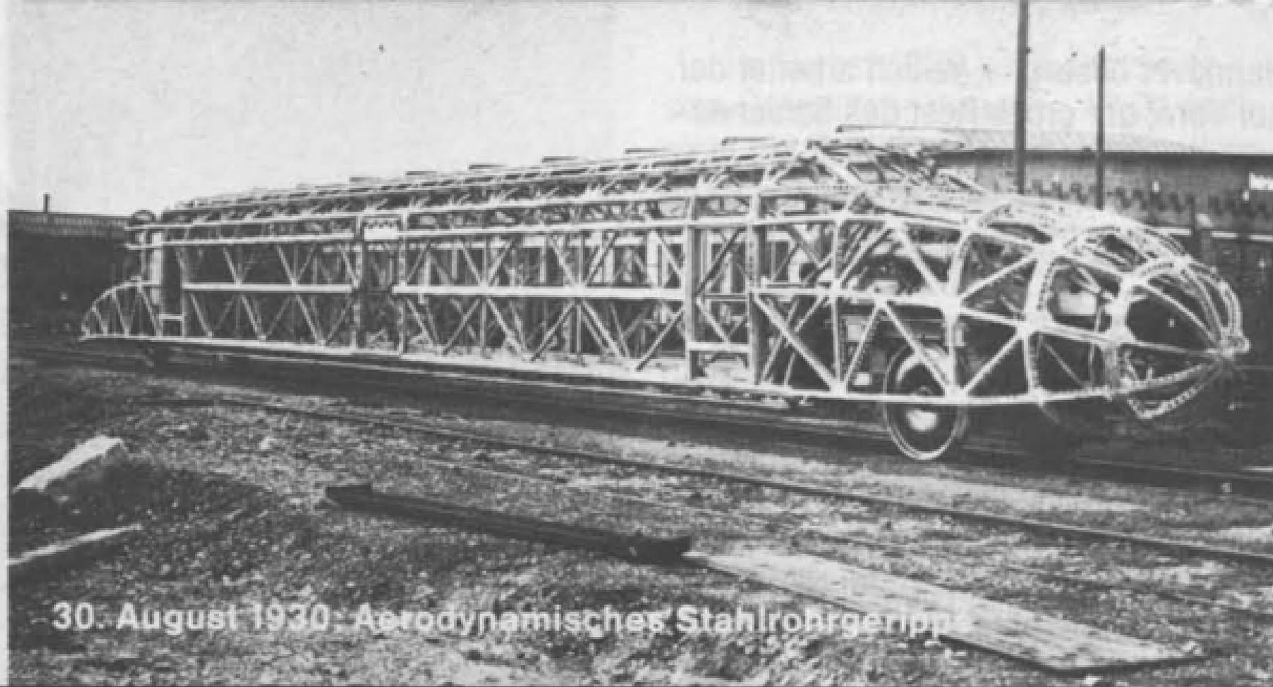
30. August 1930: Aerodynamisches Stahlrohrgerippe
